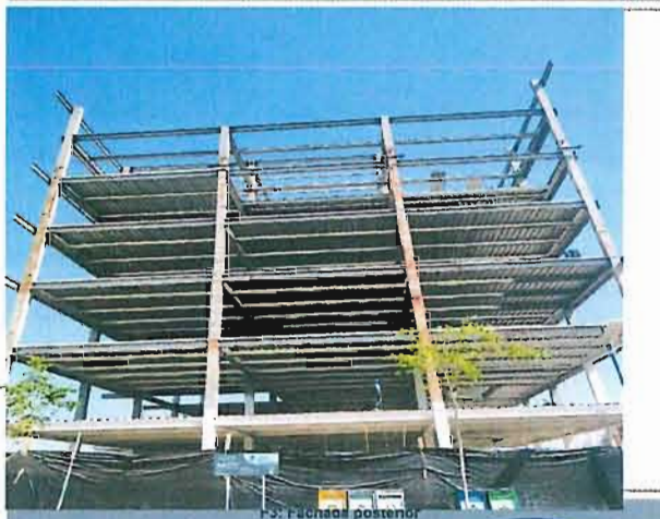
F3: Fachada posterior
