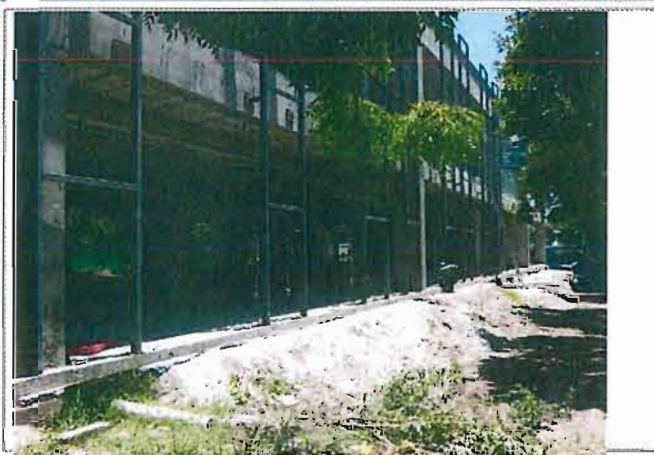
F4: Fachada posterior
