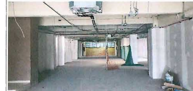
F5: Interior de edificio
